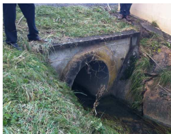
Photo aval la traversé de la route « Sortie »
