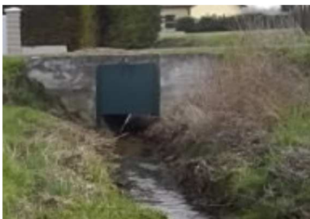
Photo amont la traversé de la route « Entrée »
